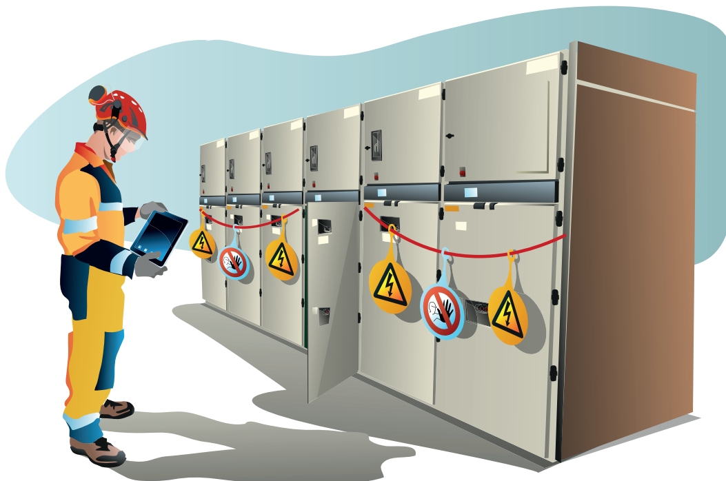
Bild 20. Exempel på avspärrningslina på ställverk.
