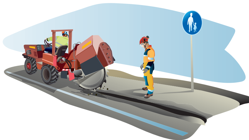
Bild 29. Fräsning av kanalisation.
