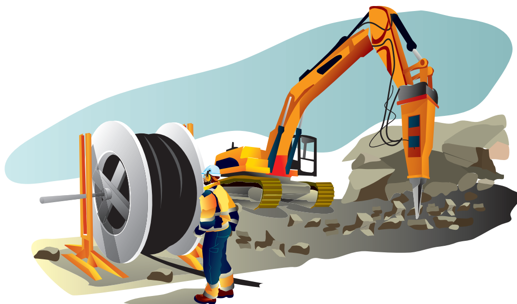
Bild 34. Knackning av berg med hydraulhammare.
