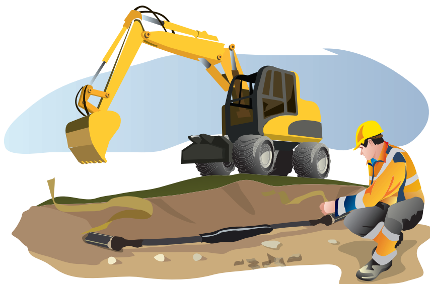
Bild 23. Tätning av rör vid kabeldragning.
