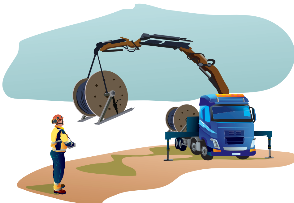
Bild 8. Avlastning av kabeltrumma.
