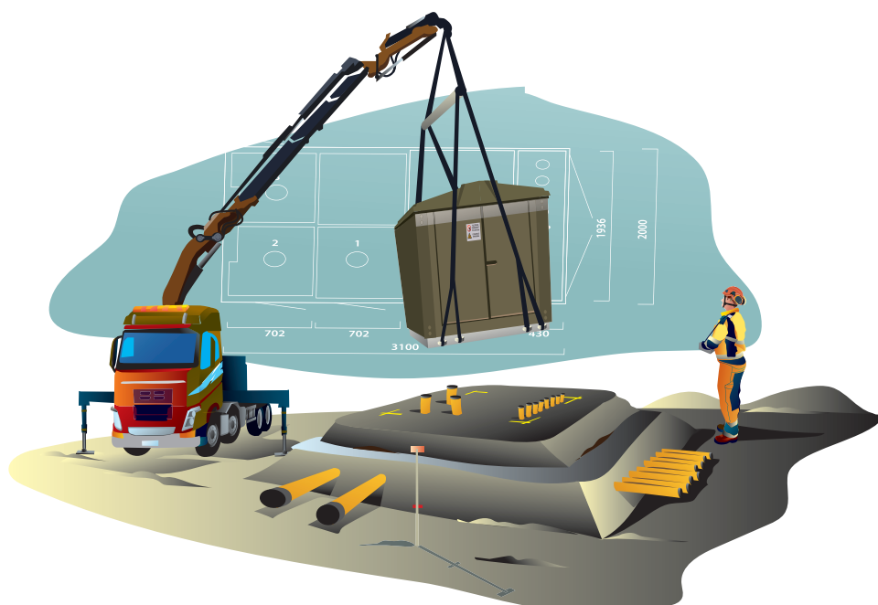
Bild 45. Sättning av station på bädd förberedd med rör.
